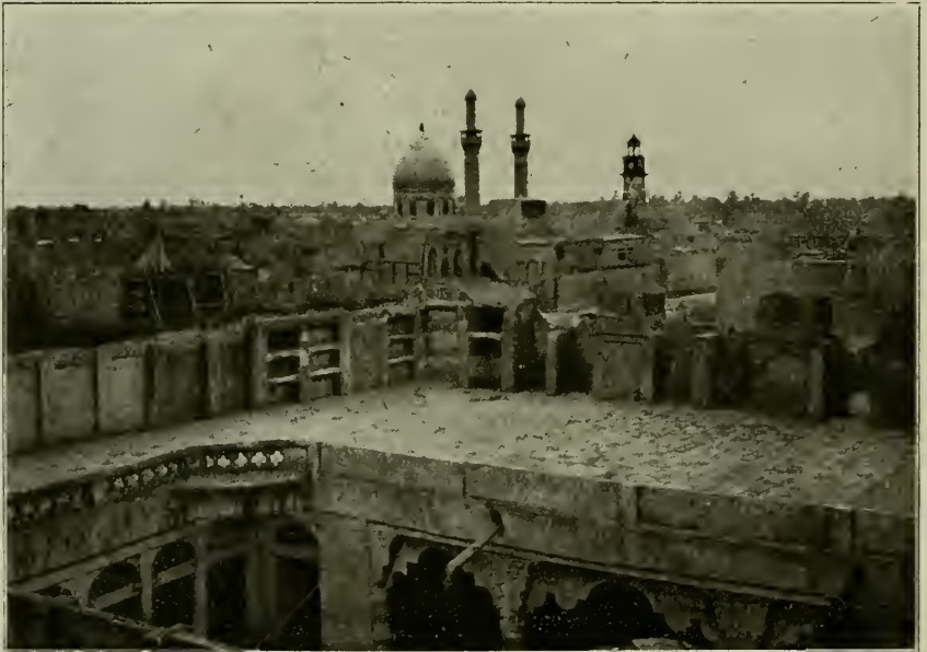
Abb. 13. Südlicher Baustil: Flachdächer und Stein- oder Lehmhäuser in Kerbela
